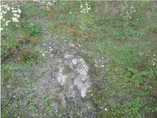
Apparition géotextile
